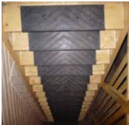
**Назначение:** резиновое покрытие «Лесенка» предназначено для покрытия лестничных ступеней, и защищает углы ступеней от разного рода механических и физических воздействий, обледенения ступеней, служит для очистки обуви от уличной грязи, уверенного и комфортного подъема по лестнице. Применение атмосферо-износостойкой резины позволяет использовать покрытие при низких температурах в зимнее время.
